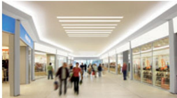
In der modernen Architektur sind Lichtvouten ein anspruchsvolles Gestaltungselement. Wichtig bei der Realisierung ist es, die charakteristischen Dunkelzonen an den Leuchtmittelübergangsstellen durch ausreichende Überlappung der Leuchtmittel zu verhindern. Auch regelbar mit Schnittstelle 1-10 Volt oder DALI lieferbar.
