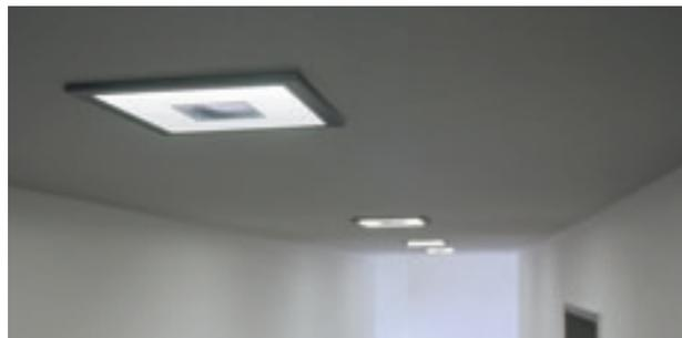
Lichtoptische Abschlusselemente erzeugen neben der diffusen Abstrahlung durch die große Leuchtfläche, zusätzlich ein gerichtetes Licht, das durch die Reflektoröffnung direkt und blendfrei abgestrahlt wird.
